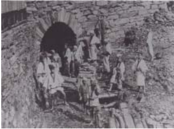
第一通洞南口 (明治14年) (住友史料館所蔵) 江戸時代以来の鑛着をまとった鉱夫。アーチ型石積み of のトンネルや鉄軌道・トロッコに近代化の息吹を感じさせる。
