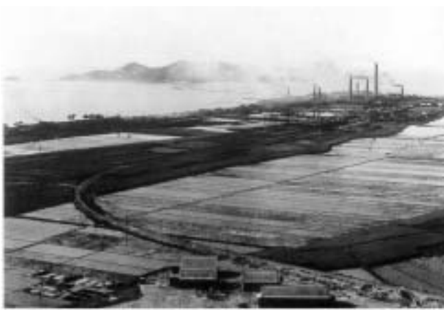
惣開全景 (明治30年代) (住友資料館所蔵) 明治21年、新居浜の海岸部、惣開に様式製錬所が創業を開始。同26年、煙突から出る亜硫酸ガスによって、農作物が枯れる煙害問題が起こった。
